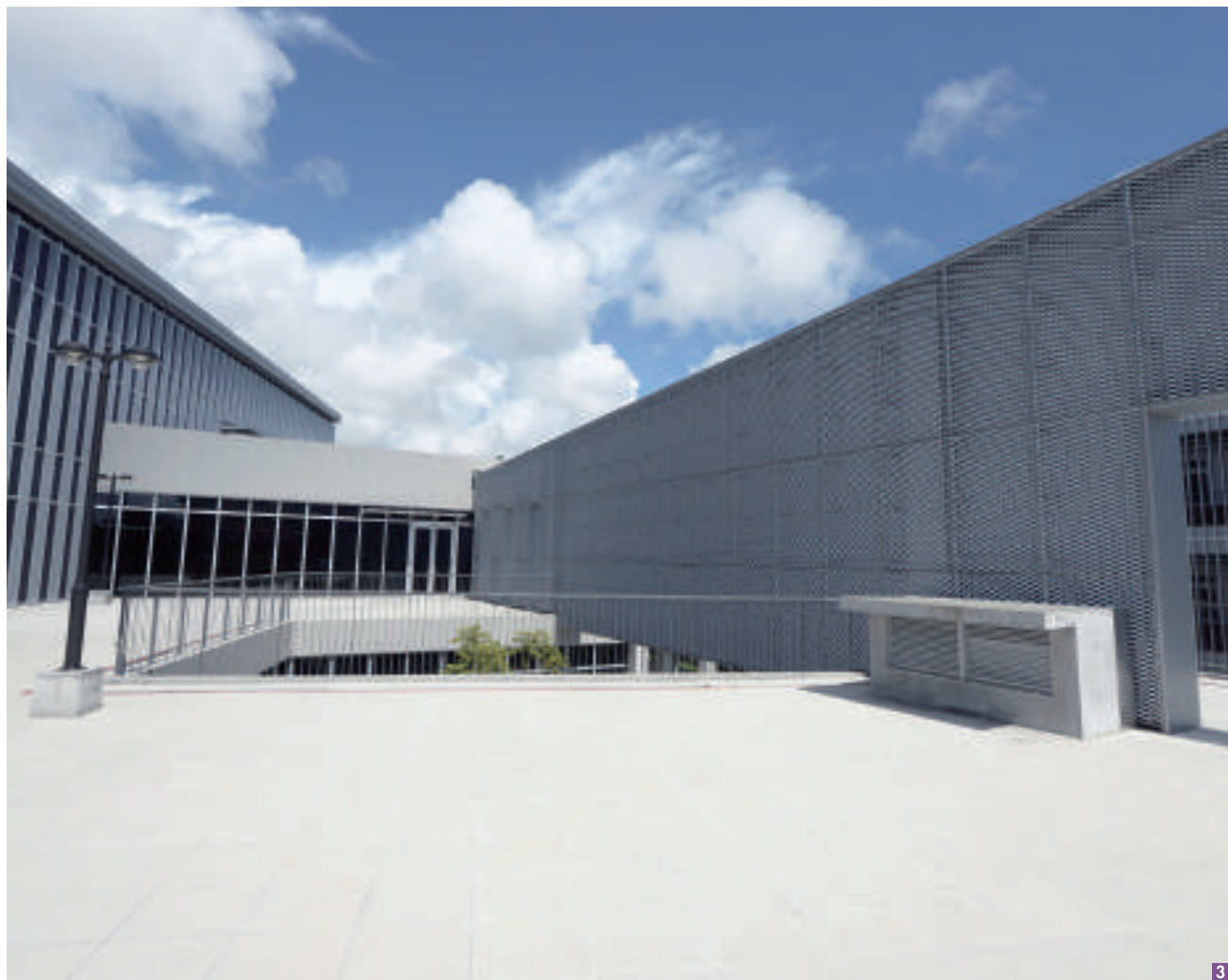
1_ 上鎧鋼鐵菱形的金屬擴張網於行政院農業委員會屏東農業生物科技園區之應用。 2_ 高雄捷運的天花板，運用上鎧鋼鐵的菱形金屬擴張網，包裹整個捷運站裡重要的工程管線。 3_ 高雄市立圖書館草衙分館入口旁的戶外造型牆面採用上鎧鋼鐵研製的獨立裝框設計，呈現外型輕盈、線條流暢的金屬網牆面。
