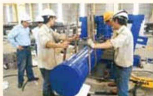
管排彎管設備組裝
