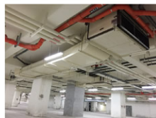
▲ 風機安裝實照
