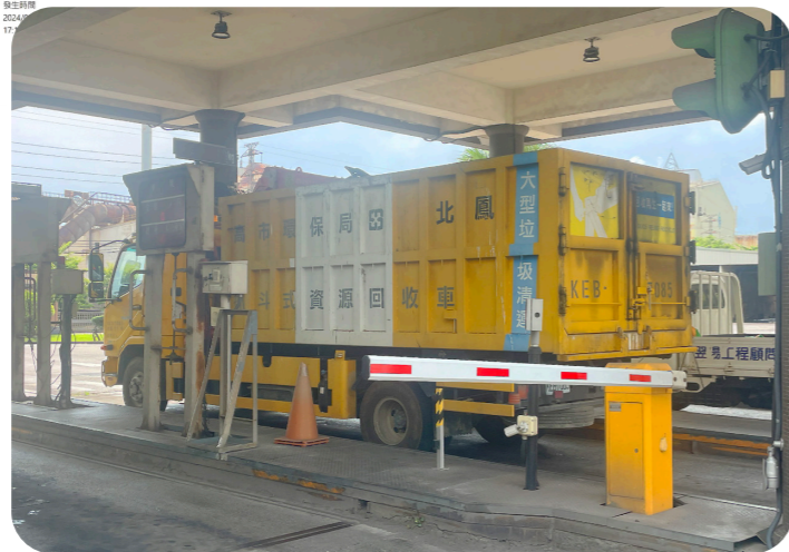
實際安裝現場
