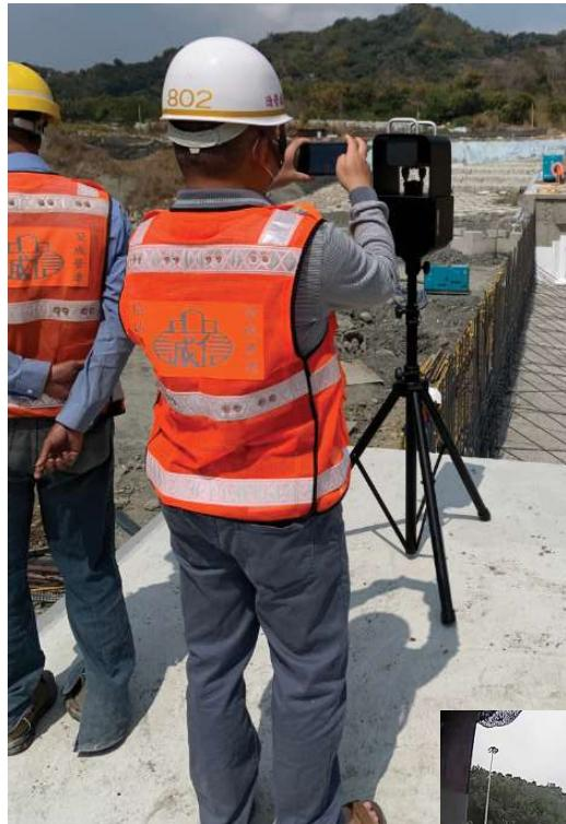
近期部分工程引進移動式 CCTV 監控系統，可針對施工重點區域進行監控，結合人工智慧影像分析技術，5G 無線傳輸技術將影像傳回至影像分析平台進行智能分析，主要功能是針對工地人員安全裝備辨識、電子圍籬禁區管制、人員肢體偵測 - 跌倒偵測，並結合社群軟體進行警示提醒。
