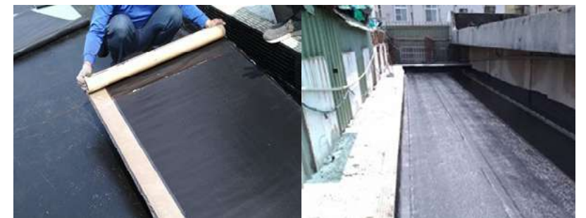
/ 計畫成果：熱熔膠防水膜施工及完工圖
