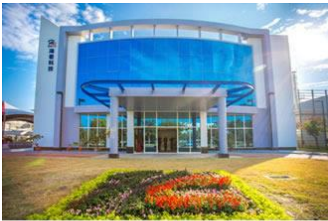
鴻君科技-高雄科學園區（路科廠）
